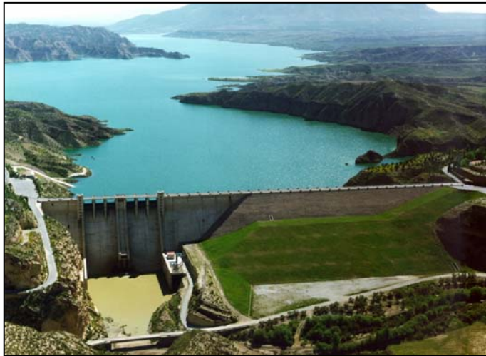
Foto 4: Vista aérea de la Presa y Embalse del Negratín, con el cerro del Jabalcón al fondo
